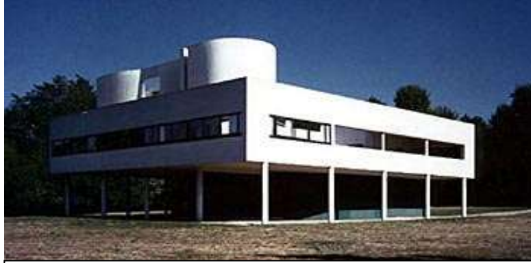
الشكل رقم (8): فيلا سافوي التي صممها لوكوربوزييه وفق طراز الحدائثة حيث تظهر فيها النقاط الخمسة التي كان لوكوربوزييه يطبقها في تصاميمه. المصدر: [FAZIO ; MOFFETT ; WODE HOUSE,2008]
