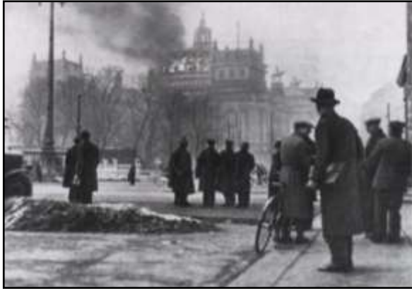
الشكل (2). المبنى محترقا في العام 1933
