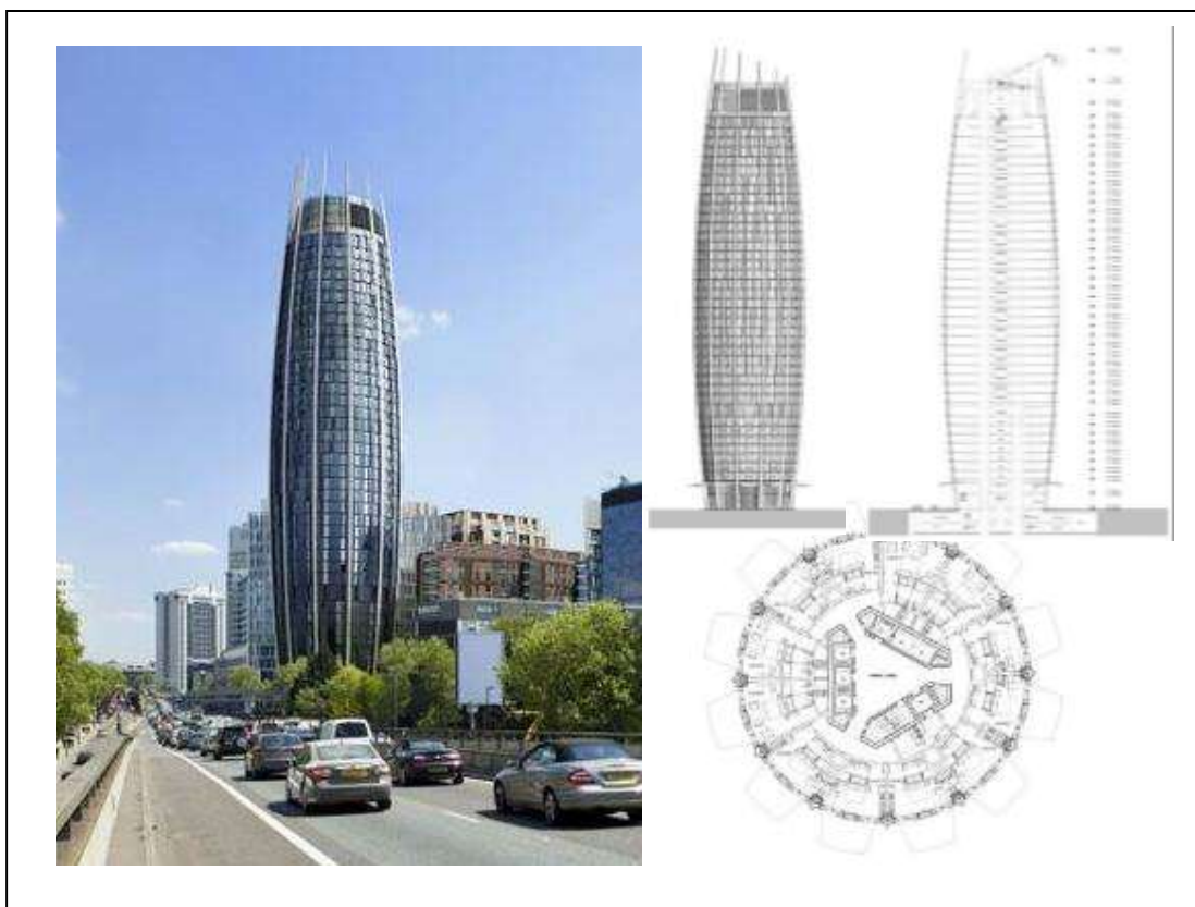
شكل (3) يبين برج Paddington Tower - لندن - 1999 - 2004 يبين كيفية دمج العناصر الثابتة في النظام الإنشائي والوظيفي مما يوفر مرونة عالية للوظائف [10]
