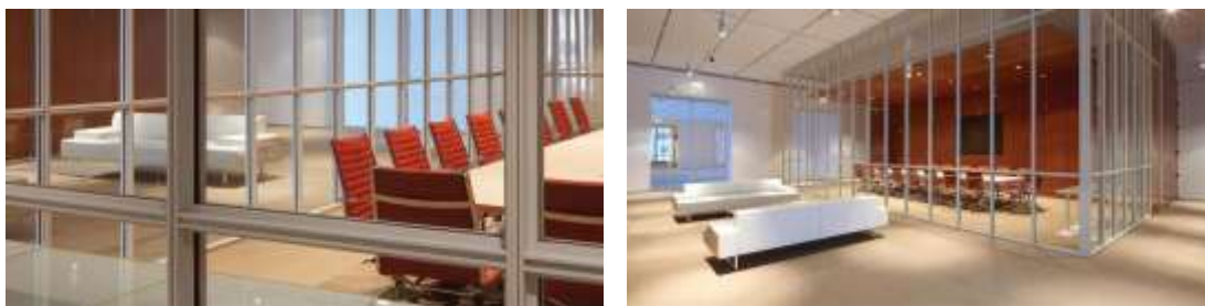
شكل (10) يبين استخدام القواطع الداخلية المتحركة وبإمكانية مرنة لتحريك هذه القواطع لتغيير وظيفة الفراغ مما يحقق مرونة عالية. [9]
