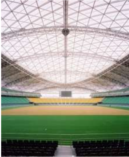
الشكل رقم (8) استخدام الفكرة الانشائية للقبوات من المواد التقليدية في مجازات الملاعب الرياضية بمواد تحقق مرونة تصميمية وانشائية ووظيفية كبيرة [14] [15]
