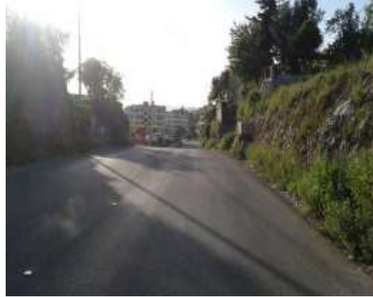
الشكل (3) عدم التلاؤم بين العناصر الأفقية و الشاقولية للطريق (ظاهرة غطس مسار الطريق)
