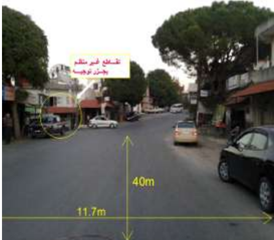
الشكل (7) تقاطع غير مصمم بشكل مناسب بدون إشارات أو توجيه للحركة بالإضافة إلى مسافات رؤية غير كافية
