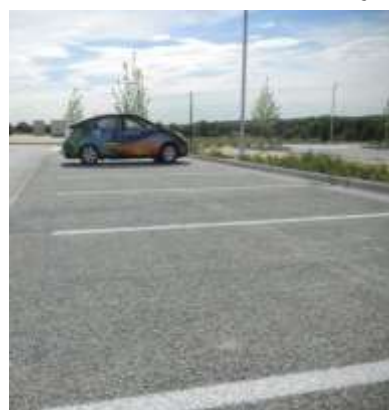
الشكل (5): استخدام البيتون الخالي من الرمل في رصف مواقف السيارات
