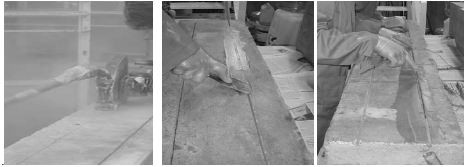
(a) فتح الشقوق (b) تطبيق اللاصق (c) وضع شرائح CFRP ضمن الشقوق
