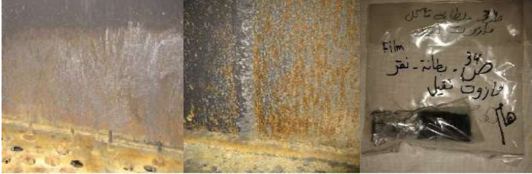
الشكل (8): نواتج التآكل ومظهره عند مستوى الصينية رقم (13).
