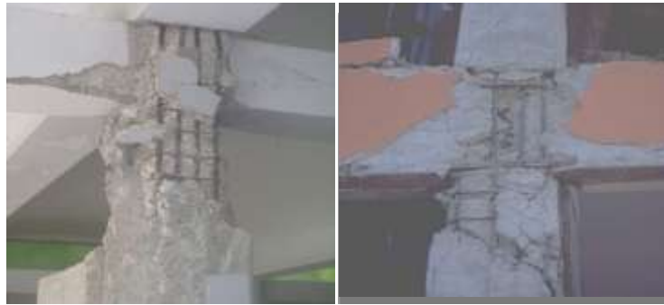
شكل (1-3) صور لعقد بيتونية متضررة نتيجة أحمال زلزالية.
