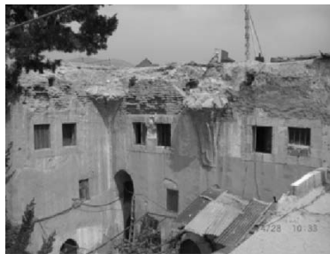
صورة (21) الفناء الداخلي الثاني
