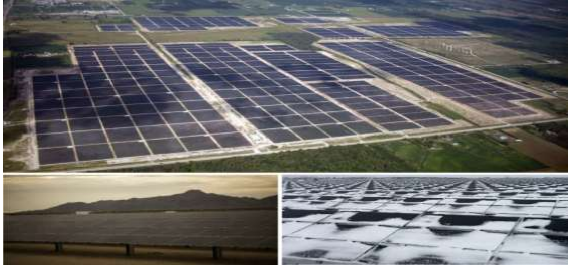
الشكل (2) حالات تظليل منظومات كهروضوئية ناتجة عن الغيوم والثلوج والأشجار.
