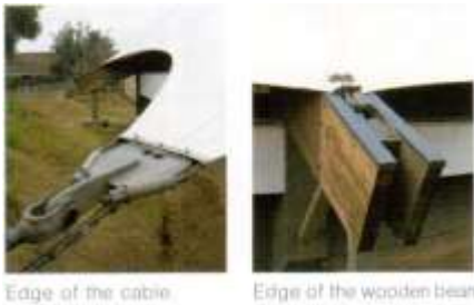
الشكل (33) يوضح طريقة تثبيت الغشاء على الحائز الخشبي [7]
