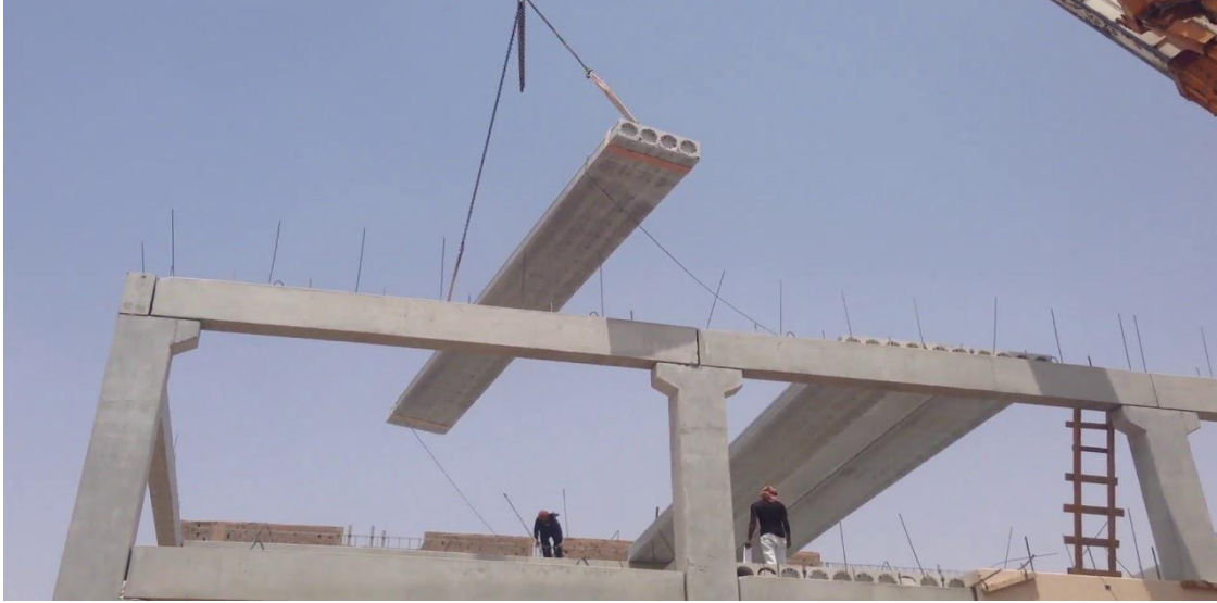
الشكل (4): طريقة التشييد مسبق الصنع.
