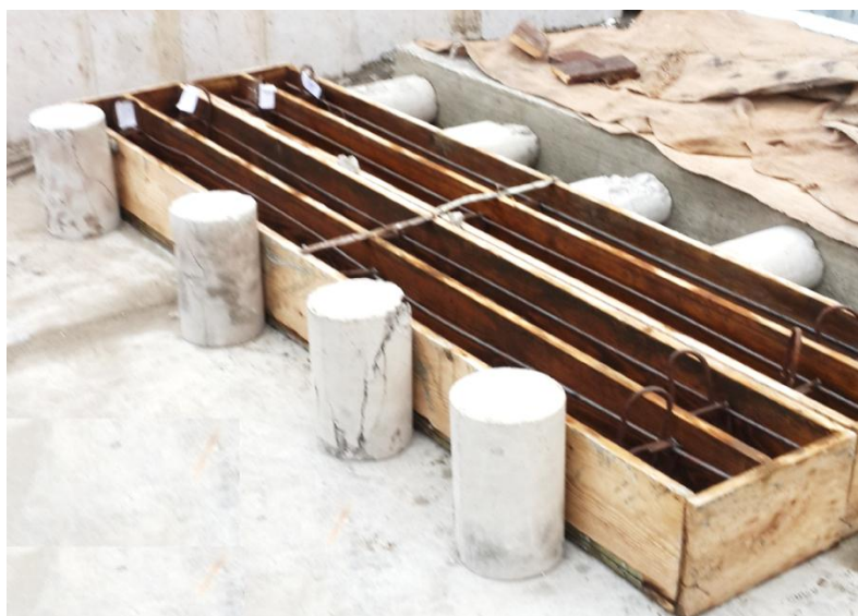
الشكل(6) الهيكل الفولاذي ضمن القوالب الخاصة الجاهزة للصب.
