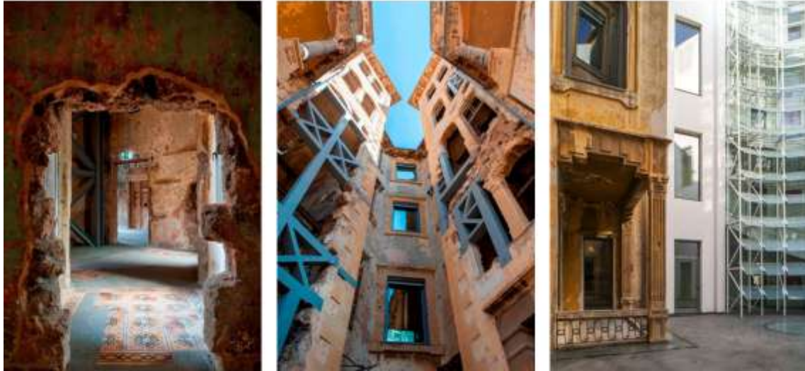
الشكل رقم (3): تفاصيل من "بيت بيروت" بعد الترميم توضح التجاور بين المرمم والجديد، العناصر المضافة الداعمة، الحفاظ على تفاصيل آثار الحرب والدمار على الواجهات وفي الفراغات الداخلية - المصدر: يوسف حيدر [38]
