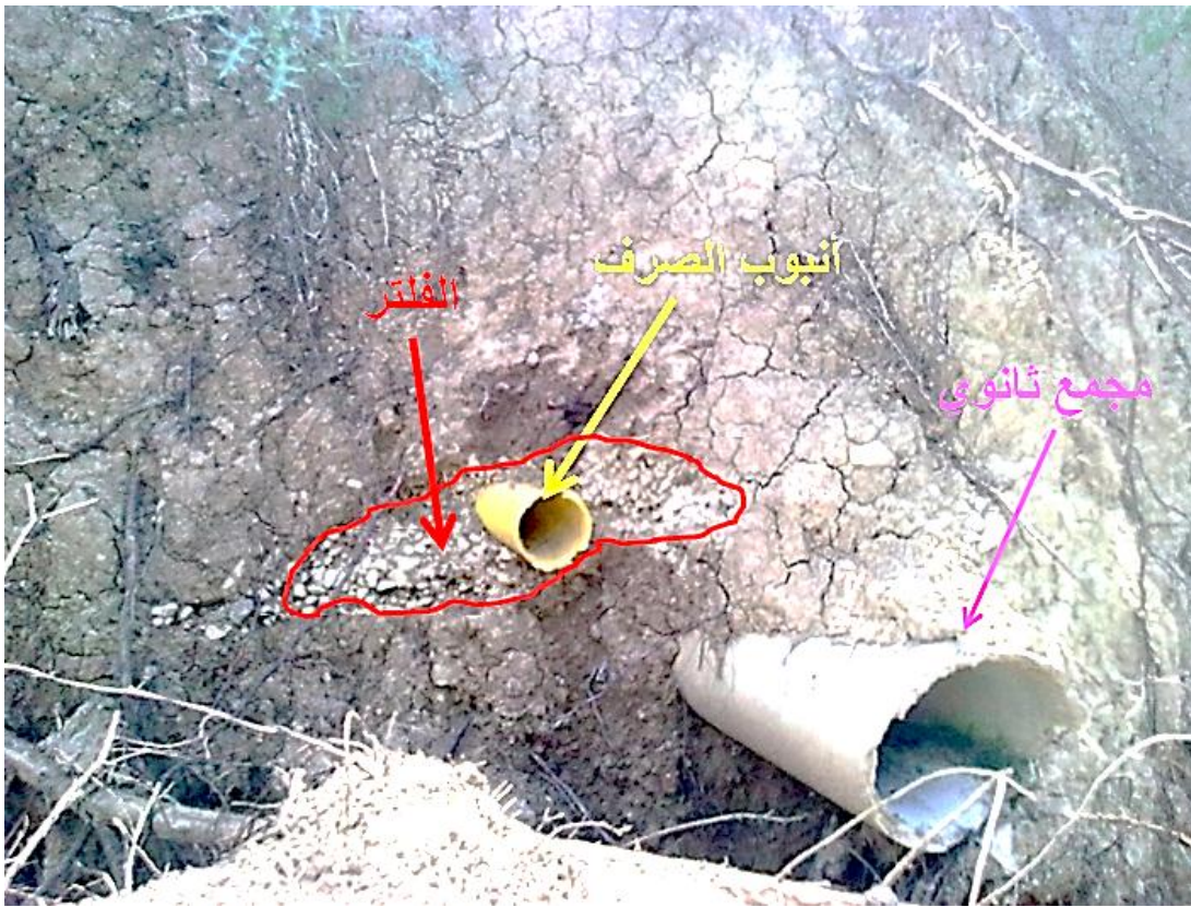
(الشكل -1). التصميم الخاطئ للفلتر المستخدم في محطة بحوث ستخريس.
