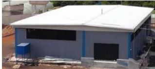
الشكل (3): سقف بألواح سندوشية لمعمل محلي
