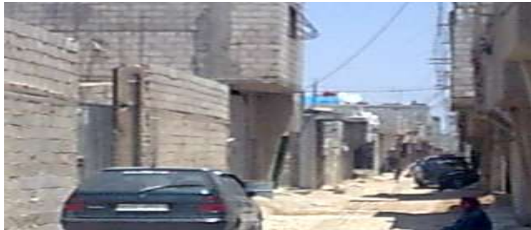
الصورة ( 6 ) أبنية سكنية عشوائية في حي غزال
