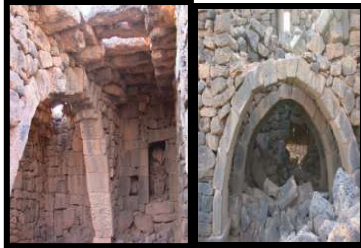
الصورة رقم (2 و 3) نظام القناطر الذي كان متبعاً في بناء مساكن ناحية المسمية قديماً.
